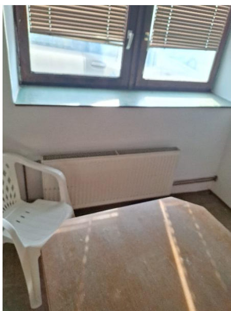
Slika 15: Radiatorji na vhodu v objektu.
