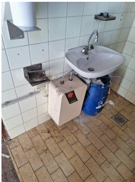
Slika 16: Lokalna priprava sanitarne tople vode.
